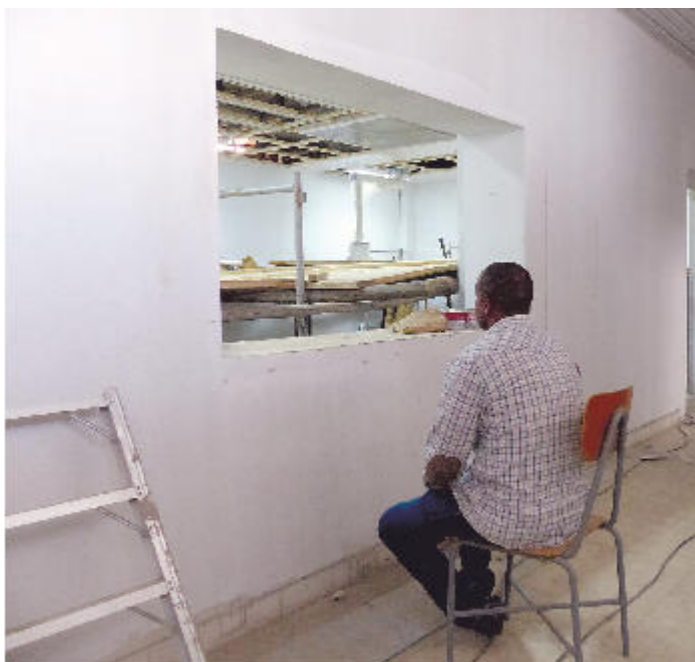
Sitzt alles richtig? Dieser Techniker probiert gerade die richtige Position der Bleischeibe mit dem Blick in den Interventionsraum aus.
